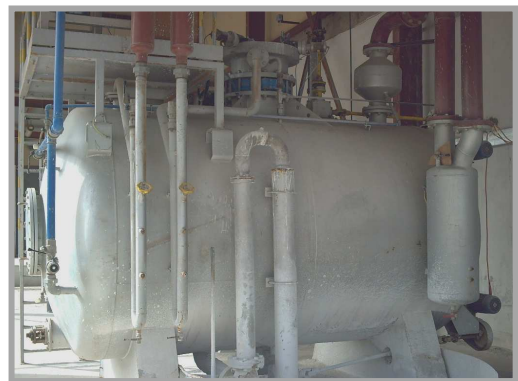
Figure 9. Le générateur d'acétylène de l'unité
