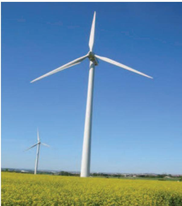
FIGURE 1.5 – Éolienne à axe horizontal
