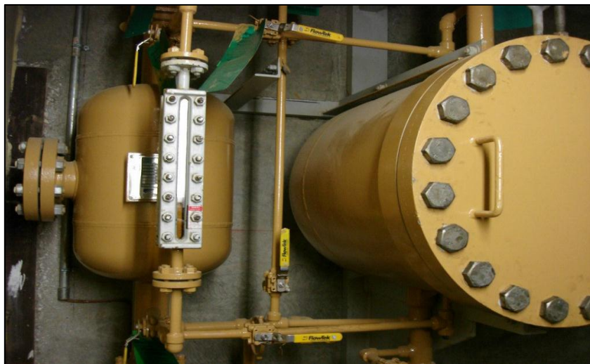
Figure 21 Réservoir vanne à flotteur
