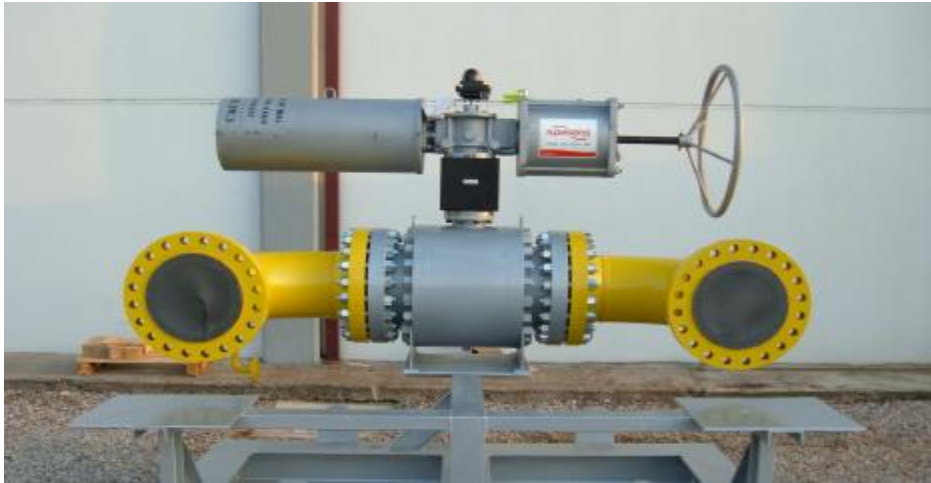
Figure 65 Vanne de tête du poste gaz de la centrale électrique Hamma II
