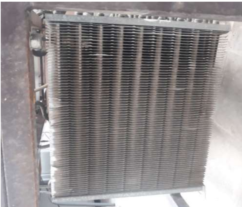
Figure 2-3 : Photo illustrant le condenseur
