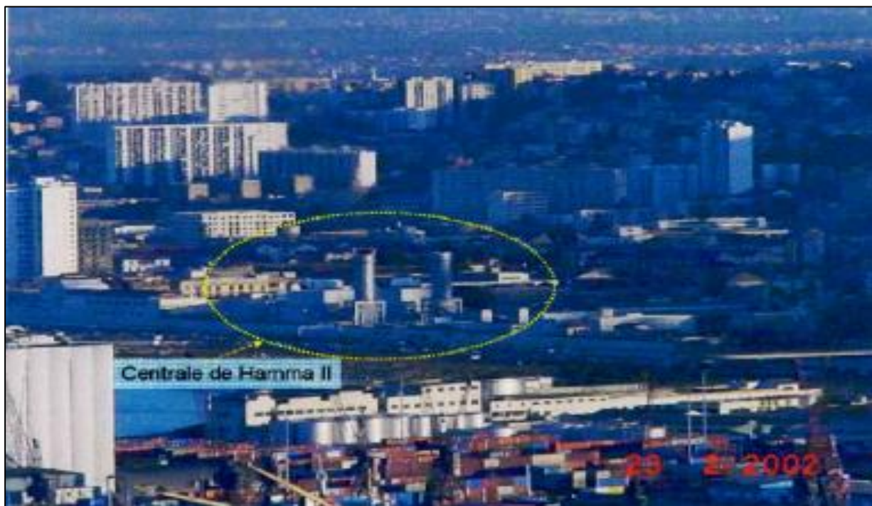
Figure 7 : vue sur la station d'El-Hamma au cœur d'Alger.
