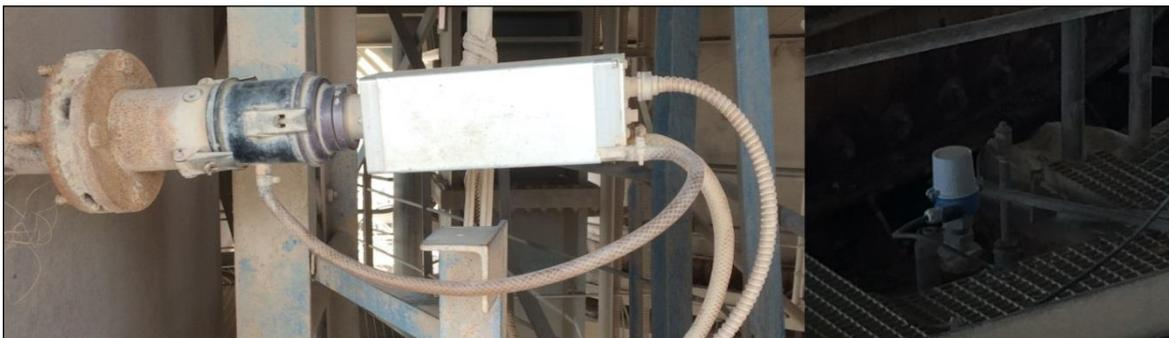
**Figure 3-6 : Matériel de mesure (à gauche un thermocouple et à droite manomètre) [EXCLUSIF]**
