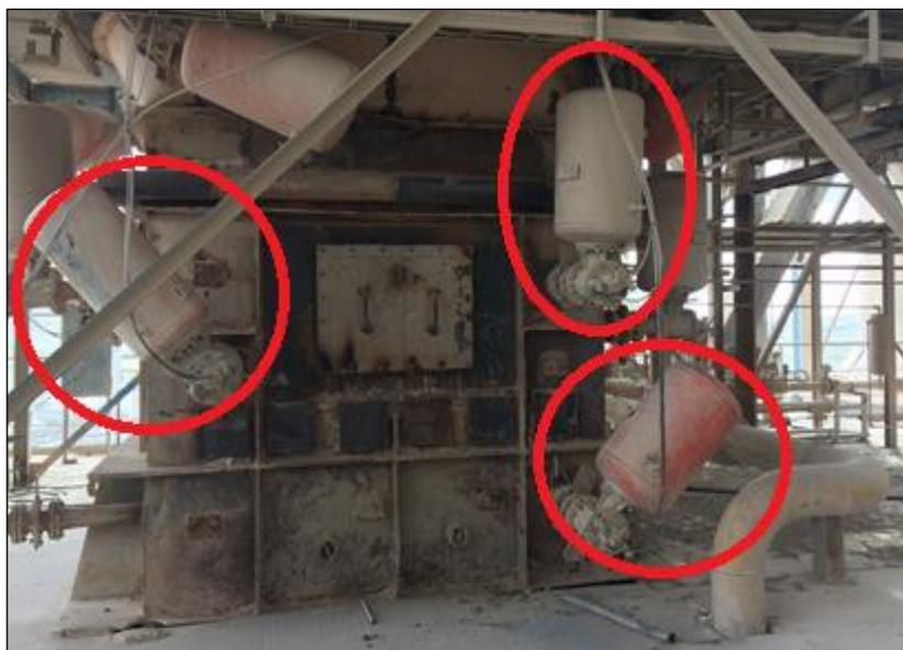
**Figure 3-7 : Disposition des air-chocs au niveau du calcinateur [EXCLUSIF]**
