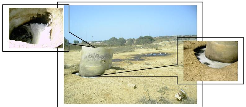
**Figure II.7:** Refoulement de lixiviats vers l'extérieur au niveau du cheminé de récupération des biogaz du Casier N° 1
