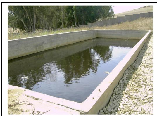
**Figure II. 8:** le bassin de décantation des lixiviats.
