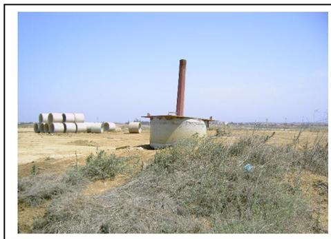
**Figure II. 6 :** Système de récupération de biogaz sans traitement
