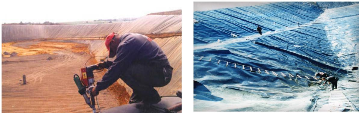
*Figure II. 4 : Mise et soudure de la géomembrane.*
