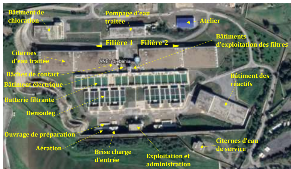
Fig 1. 5 : Photo satellite de la station de traitement de Qudiet Acerdun
