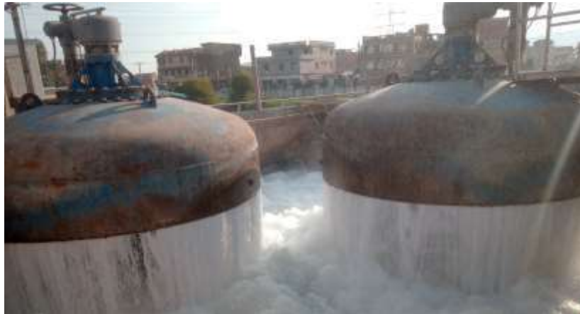
Fig 2. 12 : Deux robinets à disque auto-centreur avec vanne de régulation motorisée [5]
