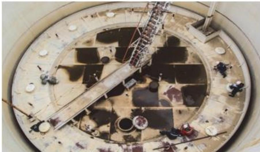
**Figure I.5: Maintenance d'un toit flottant**
