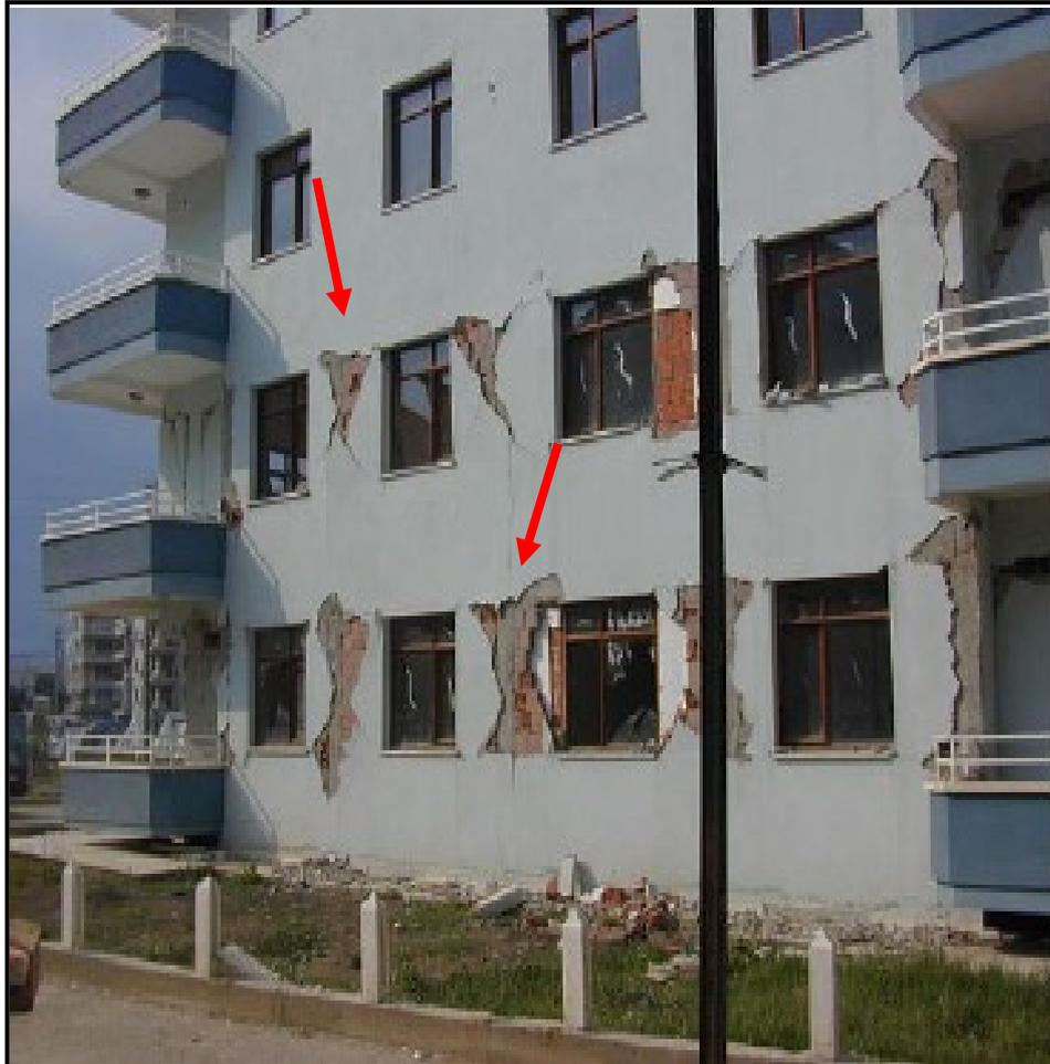
**Figure(III.9):** Dégâts modérés à un immeuble de 5 étages. Photo. Séisme de Kocaeli en Turquie 1999.
