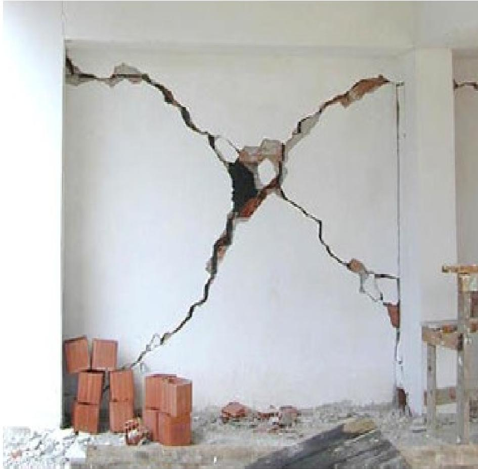
**Figure(III.9):** Fissure en X, caractéristique dans un mur de remplissage en maçonnerie.
