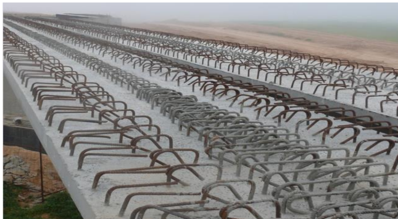
Figure 13.15: Armatures de jonction de la dalle
