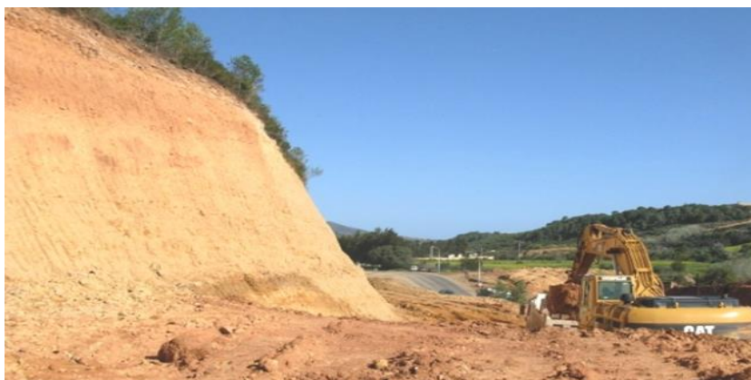
Figure 13. 1 : Terrassement du terrain
