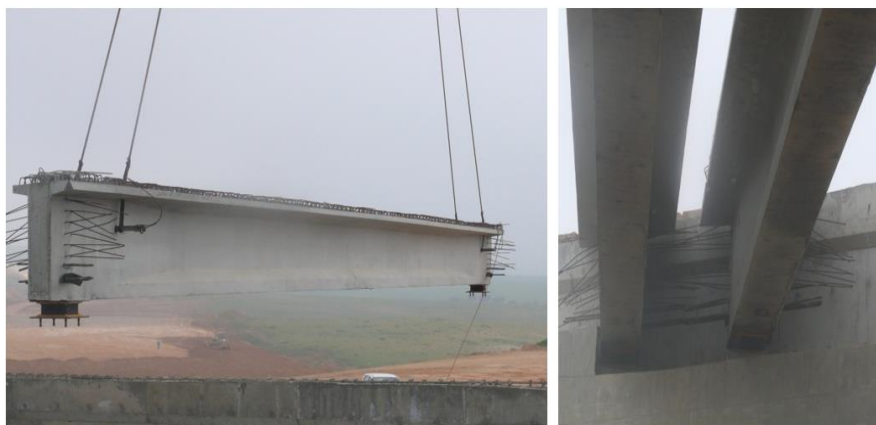
Figure 13. 14 : Pose des poutres
