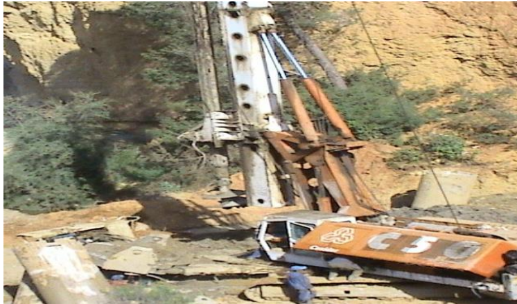
Figure 13. 2 : Forage des pieux du pont
