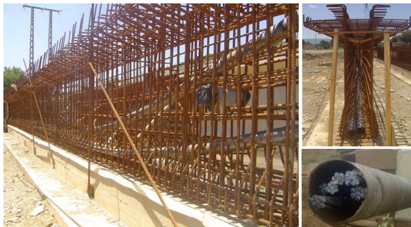
Figure 13. 17: Mise en place des armatures passives et actives
