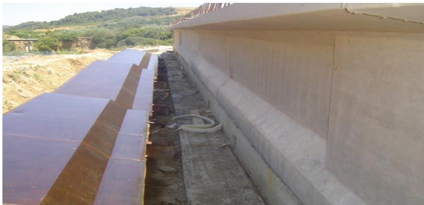
Figure 13. 19 : Décoffrage de la poutre
