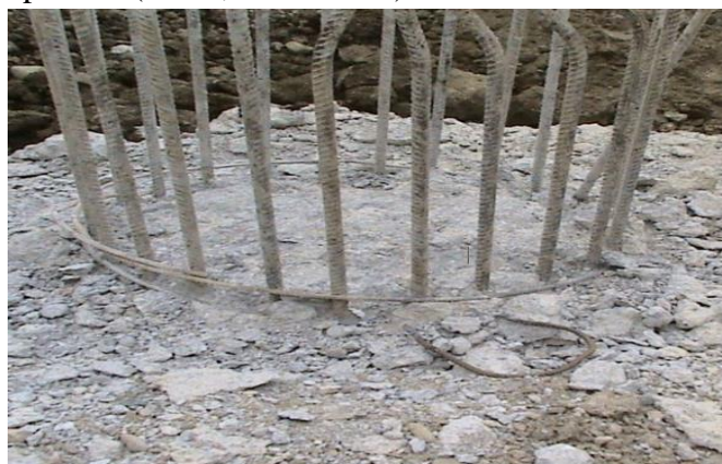
Figure 13. 5: Reçepage des pieux
