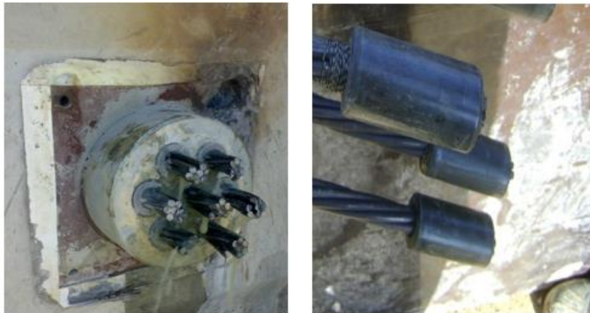
Figure 13. 18 : Ancrage fixe des armatures
