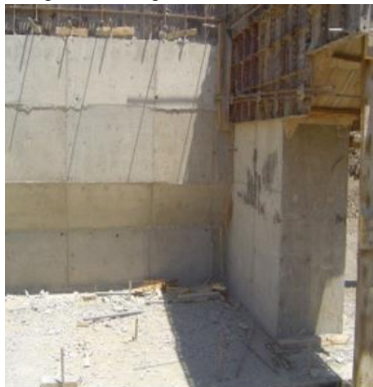
Figure 13. 13 : Coffrage du mur en retour
