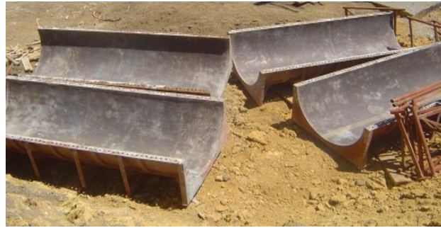
Figure 13. 9 : Coffrage des fûts
