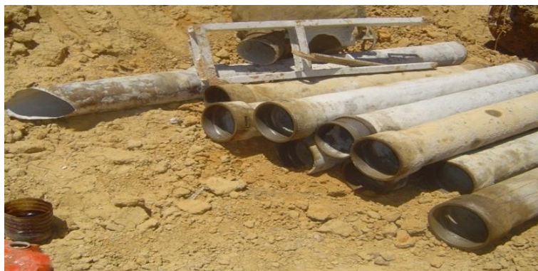
Figure 13. 4 : Tube plongeur pour bétonnage
