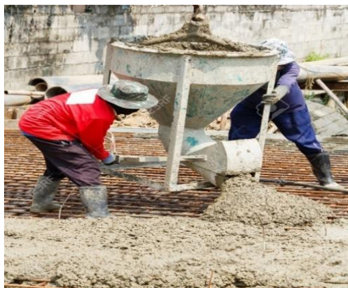
Figure 13. 6 : Mise en place du béton de propreté
