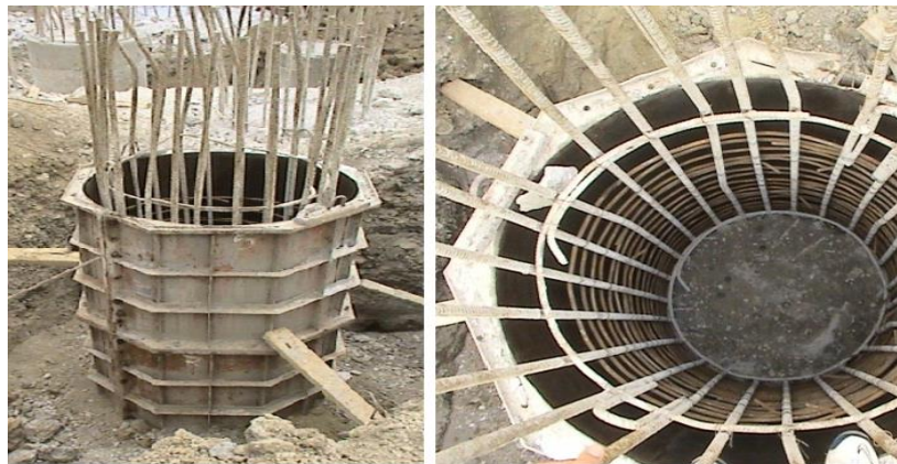
Figure 13. 3 : Cage d'armature des pieux
