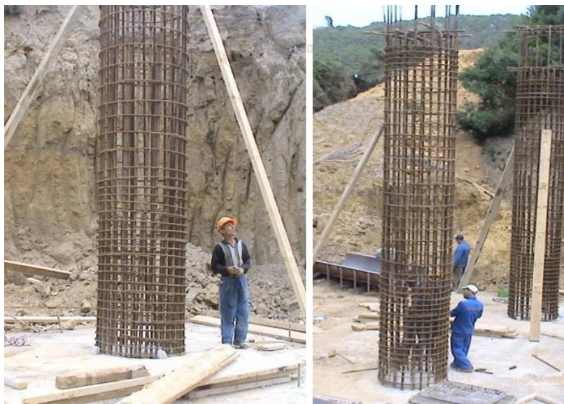
Figure 13. 8 : Ferrailage des fûts
