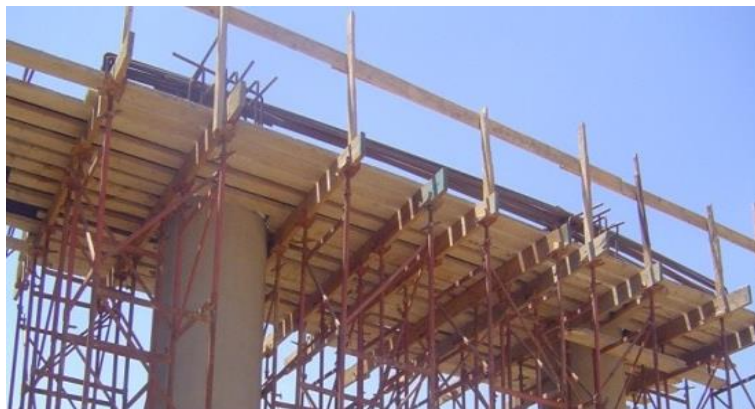
Figure 13. 10 : Coffrage du chevêtre
