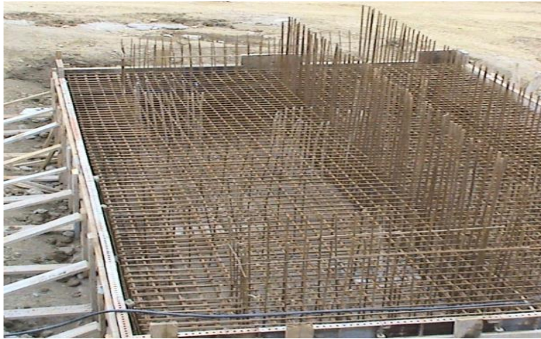
Figure 13. 7 : Ferrailage de la semelle
