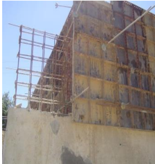
Figure 13. 12: Coffrage du mur garde grève
