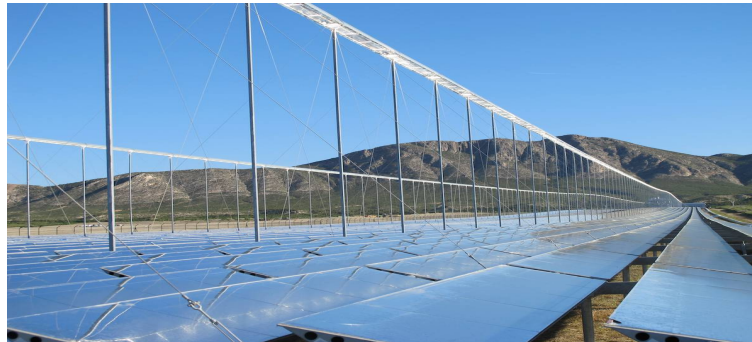
Figure 2.2: Concentrateur solaire à Miroirs de Fresnel
