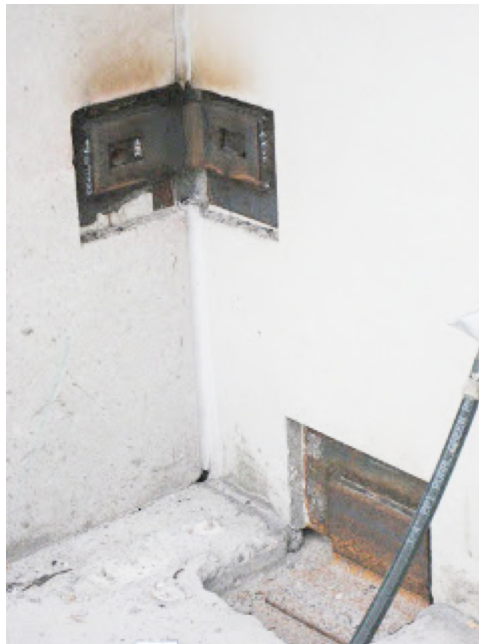
FIGURE 8.2 – Jonction par soudure
