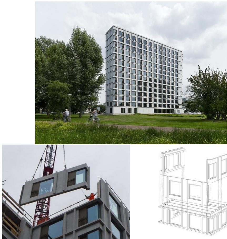
Figure 1.2 – Logement en panneaux préfabriqués, Pays-Bas
