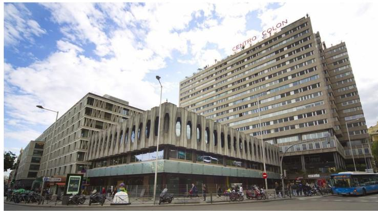
Figure 1.5 – Panneaux de façade en béton préfabriqué, Madrid, Espagne, 1969
