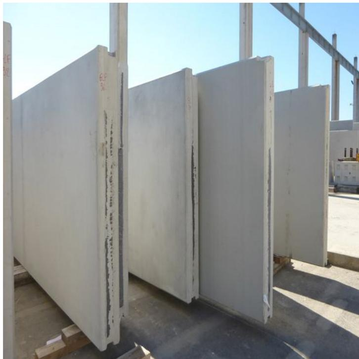
Figure 1.6 – Panneaux sandwich en béton armé
