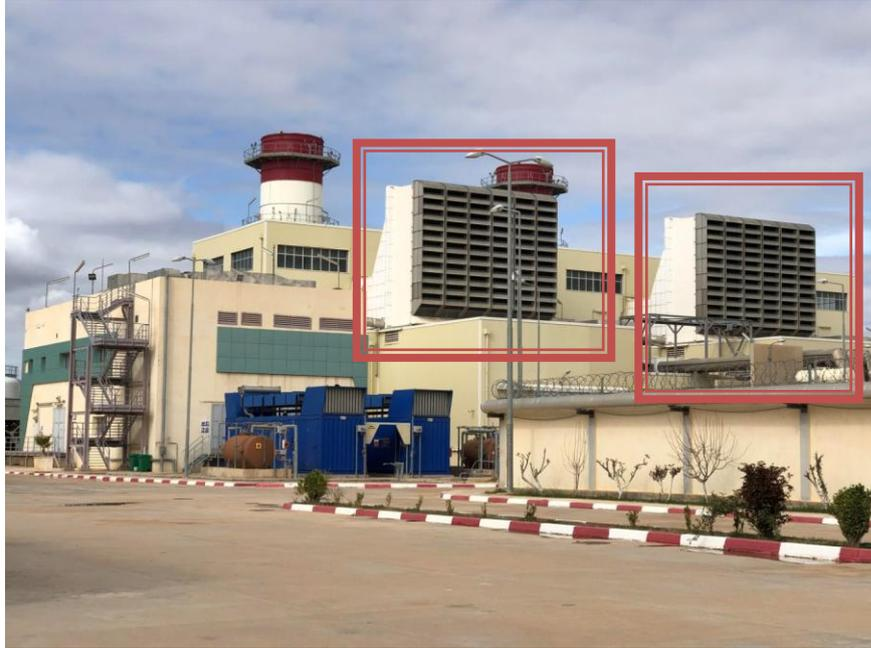
*Figure 1.6: Vue extérieurs de système d'aspiration.*
