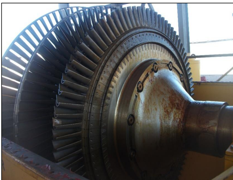
Figure 1.12: La turbine de détente de la turbine à gaz
