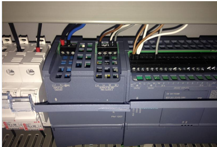
Figure 3.27. Câblage de l'alimentation
