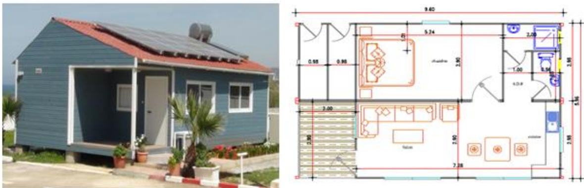
Figure 1.10. La maison solaire basse consommation située à l'UDES
