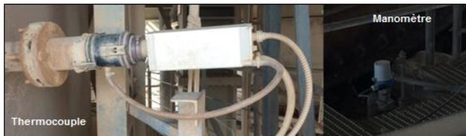
Figure3.14 : Matériel de mesure (thermocouple et manomètre) [26]
