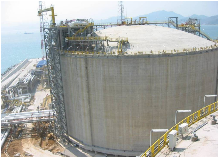
Figure II.6 : Réservoir aériens à intégrité totale [12]
