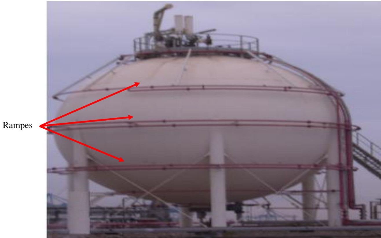
Figure 5- 1: Système de déluge par quadrillage
