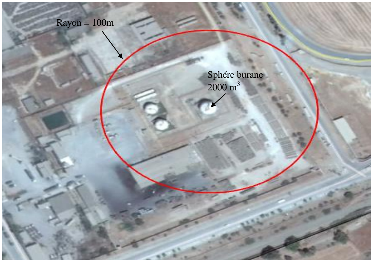
Figure 4 - 8 : Infrastructures trouvant dans le rayon de surpression P_s = 0,2
