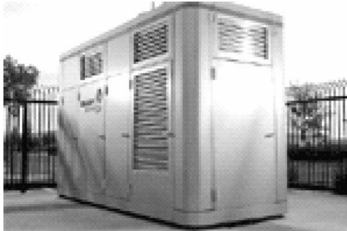
Figure 1-3 Module de génération de l'hydrogène par l'électrolyse de l'eau
