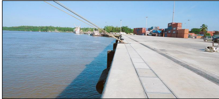
Figure II.7: Poutre de couronnement
