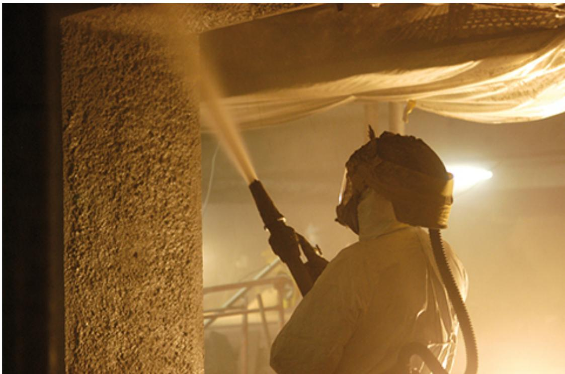
FIG. 3.4 : Renfort par béton projeté
