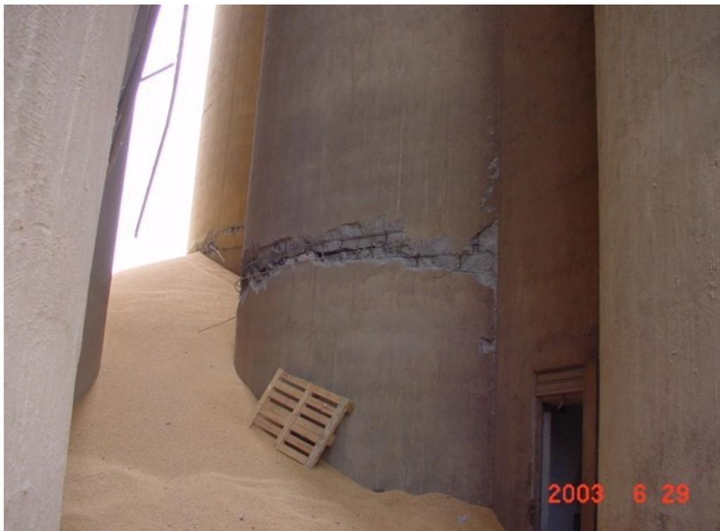
FIG. 5.29 : Fissures dans le direction Y
