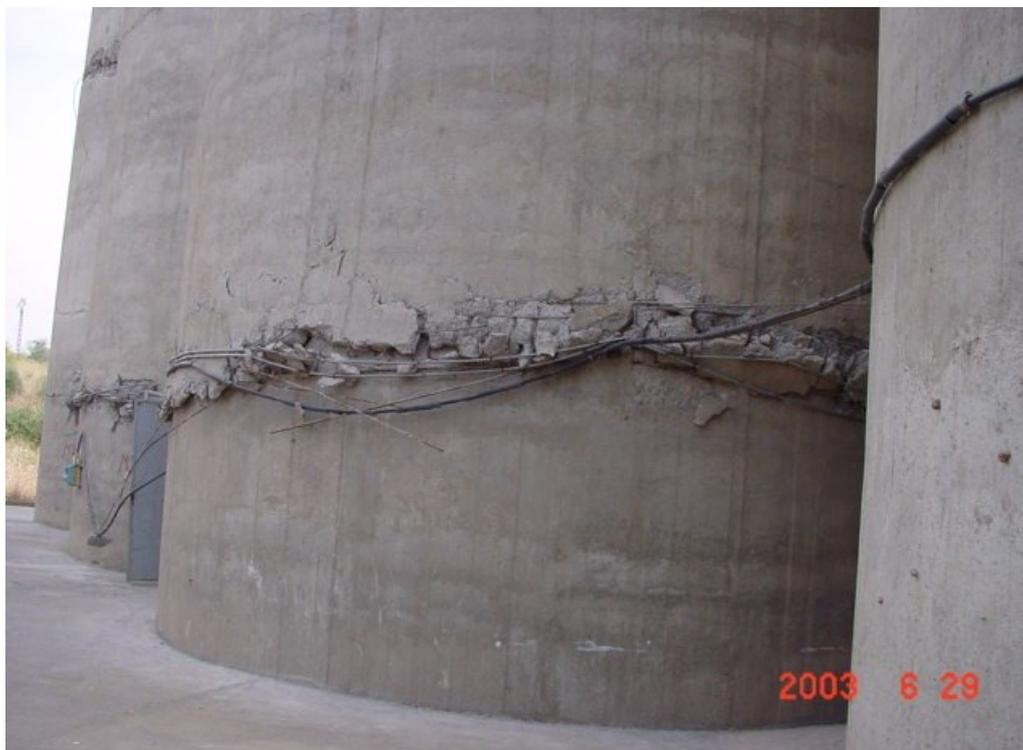
FIG. 5.30 : Dommages causés par le flambement des armatures
