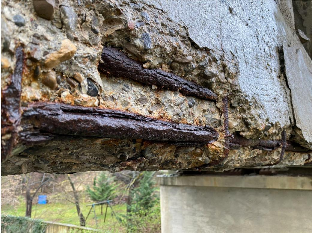
FIG. 1.3 : corrosion des aciers
