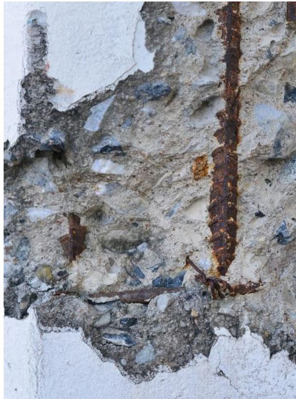
FIG. 1.2 : Effet de carbonatation sur le béton
