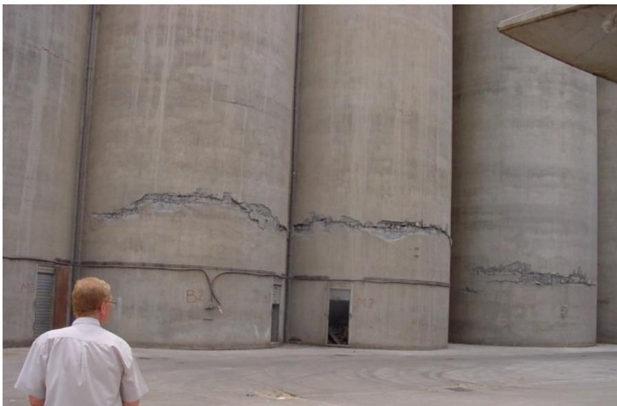
FIG. 5.28 : Fissures causées par le fond incliné
