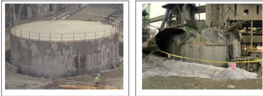
Figure 3.7:Explosion de réservoir de stockage à Lafarge Malaisie
