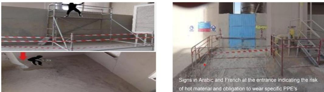
Figure 3.1: Accident de contact avec matière chaude
