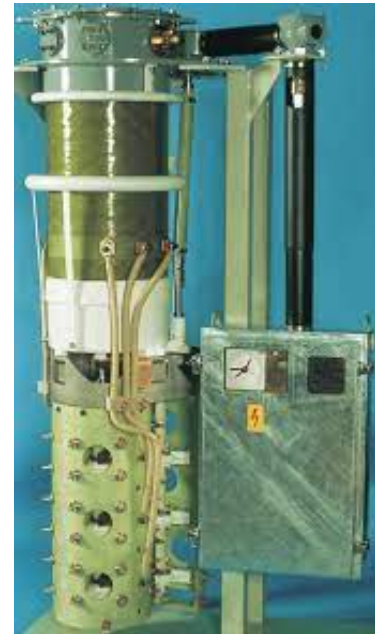
FIGURE 1.19 – Changeurs de prises en charge
