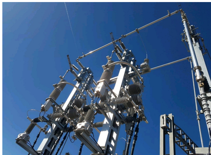
FIGURE 1.18 – Transformateur de mesure SADTEM out door
