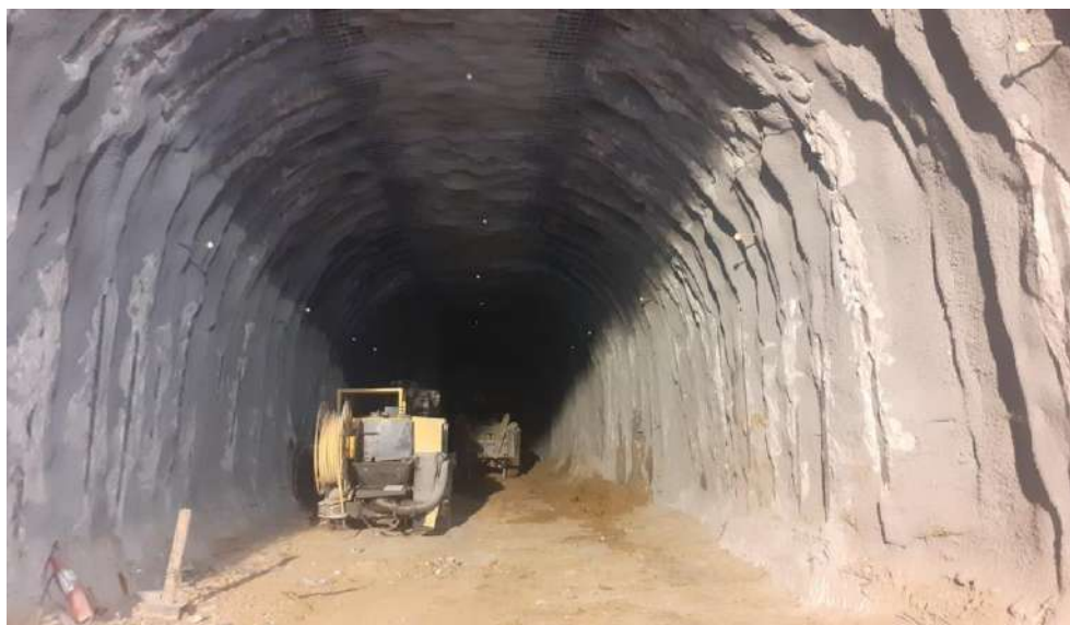
Figure 1.4 : Galerie pilote dans un tunnel d'Alger Cosider TP.
