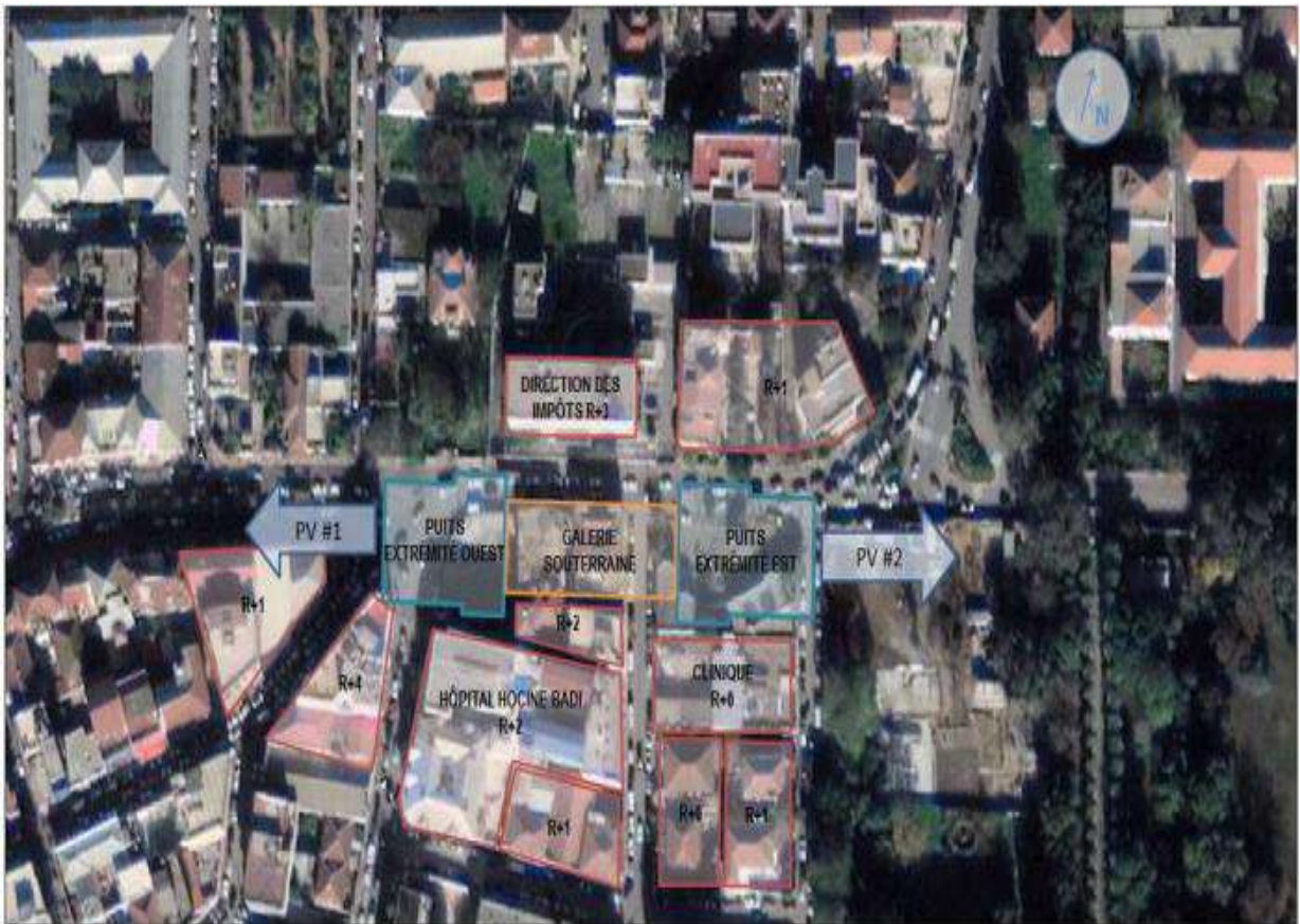
Figure 3.9 : Vue générale à la zone d'implantation de la station de Hacen Badi (Google Maps, date 30/12/2017).
