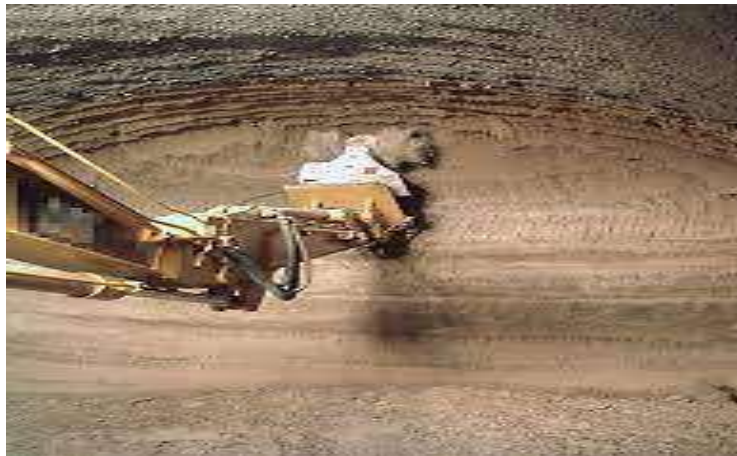
Figure 1.9 : Machine de pré-coupage (haveuse)
