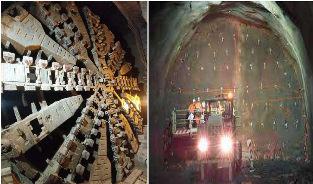
Figure 1.11: Technique de creusement en plain section: a-tunnelier, b- l'explosif.
