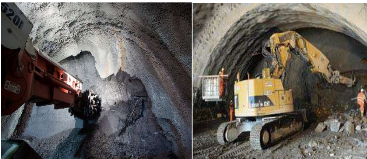
Figure 1.8 : L'excavation par l'attaque ponctuelle (haveuse)
