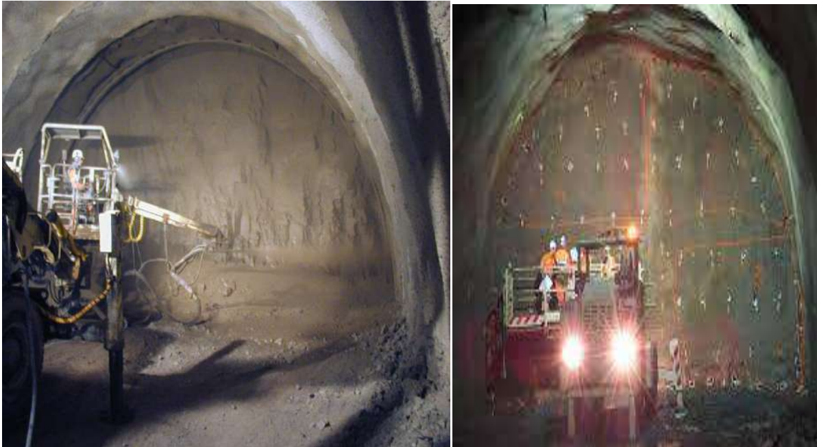
Figure 1.7 : Méthode de creusement par l'explosif (forage des trous)
