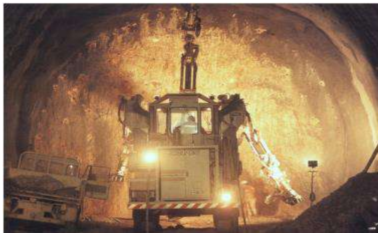
Figure 1.5 : Jumbo au travail sur le tunnel des Pennes-Mirabeau
