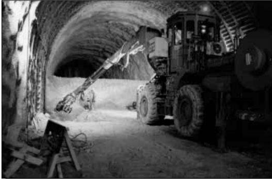
Figure 1.12 : Technique de creusement en demi section
