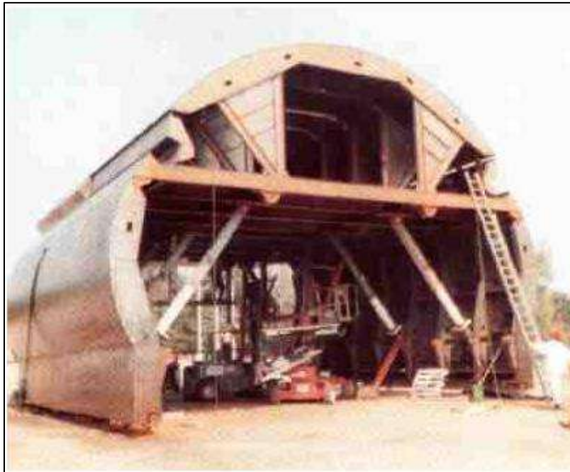
Figure 2.15 : coffrage de tunnel. [18]
