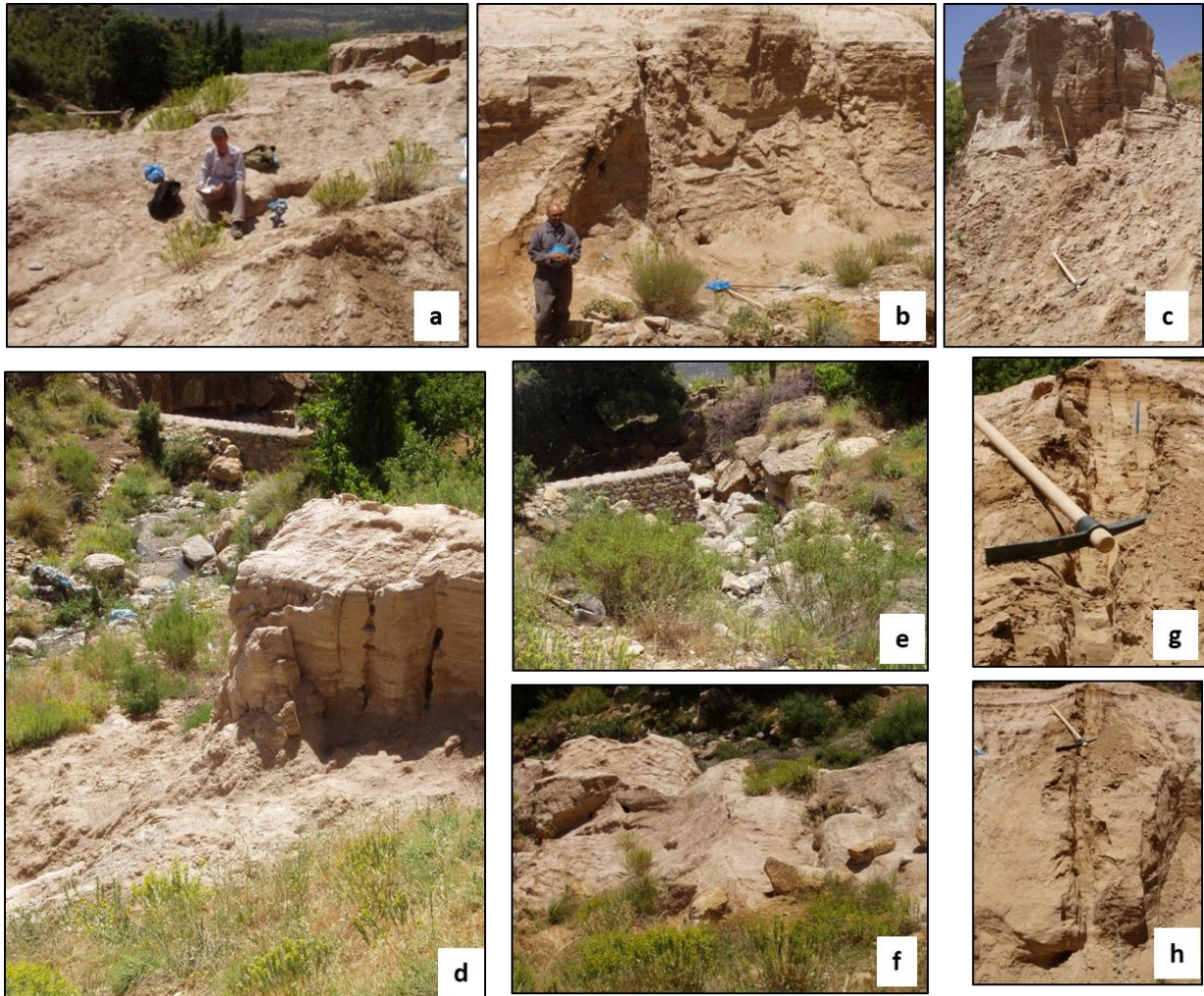
Figure 2.6 : Photos montrant l'état de la digue des résidus du site minier abandonné Ichnoul. (c) et (f) les saignées d'échantillonnage des résidus (les photographies ont été prises par l'auteur).
