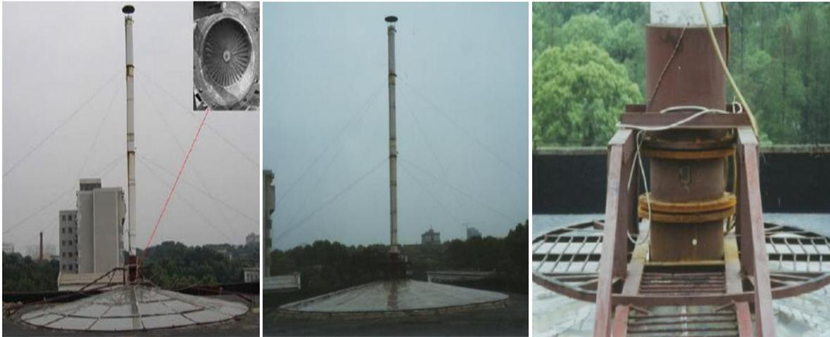
Figure II.10. Vue globale de la CCS et Aéro-génératrice placée à la base de la cheminée [25].
