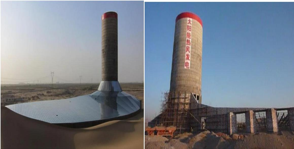
Figure I.9. Prototype de la centrale solaire à effet de cheminée chinoise [56].
