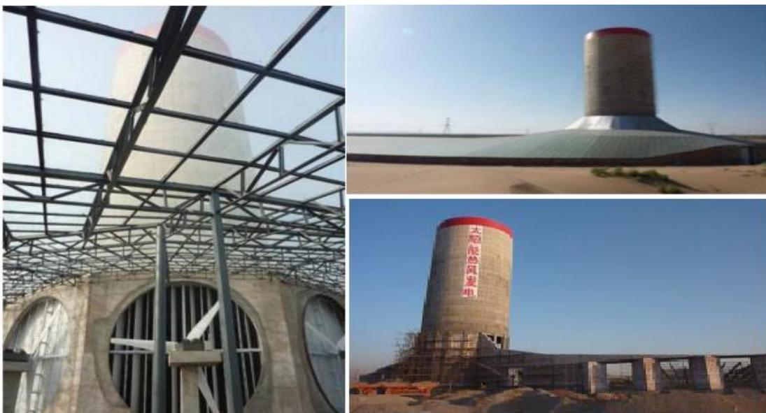
Figure II.15. Le prototype de CCS de Wei. (Entrée d'air et système) et vue de l'aéro-génératrice autour de la cheminée [34].
