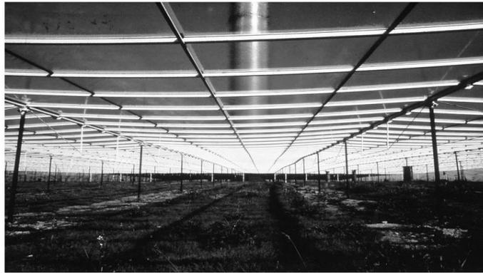
Figure III.1. Toiture en verre du prototype de Manzanares. Des averses de pluie occasionnelles ont permis l'auto nettoyage du système.
