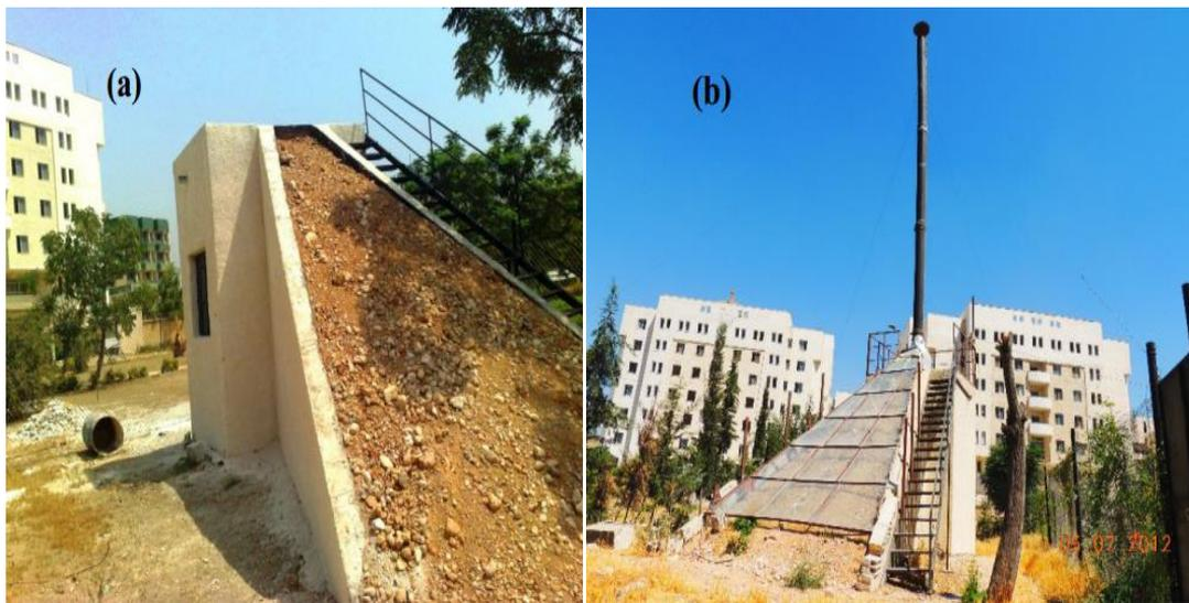
Figure II.20. Prototype de l'université de Damas, Syrie : (a) Photo pendant la construction du prototype ; (b) La CCS prototype pendant la collecte de données [42].
