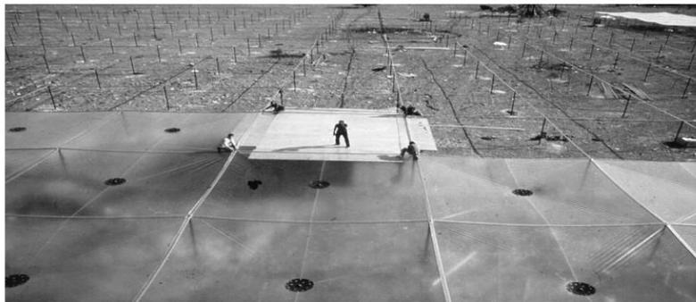
Figure III.2. Toiture en membranes plastiques utilisées dans le prototype de Manzanares afin d'établir une étude comparative avec la toiture en verre.
