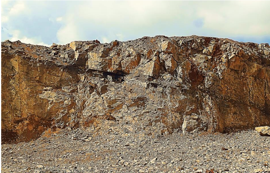
Figure I. 7. : La structure fissurale de talus au niveau 660 m.
