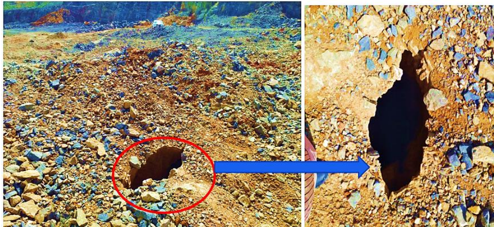
Figure II. 5. Cavitité karstique dans massif de la carrière.
