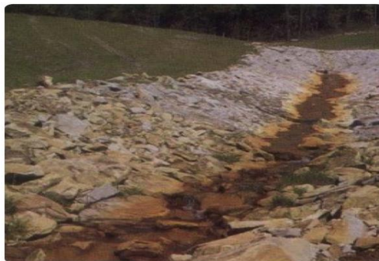
Figure 1.6 : Écoulement d'un DMA dans un DOC faisant apparaître les précipités d'hydroxyde de fer
