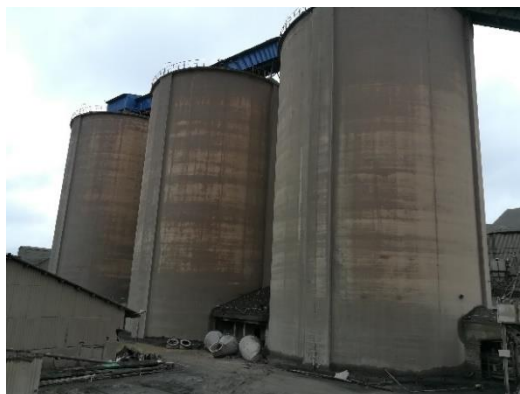
Figure 1. 12 Silos de clinker de la SCSEG
