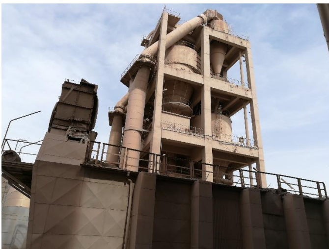
Figure 1.10 Tour de préchauffage de la SCSEG
