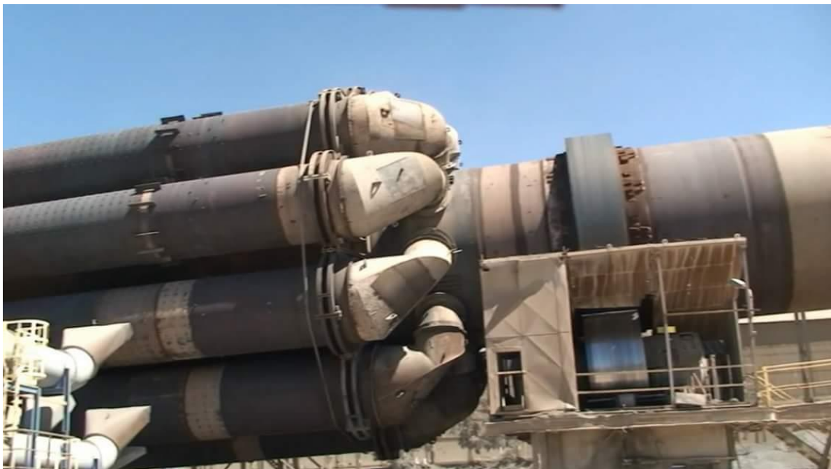
Figure 3. 6 Refroidisseur à ballonnets de la SCSEG
