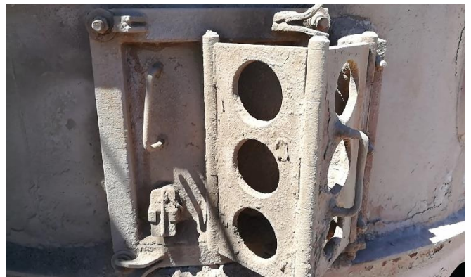
Figure 6. 5 Porte visite d'un cyclone de la tour de préchauffage
