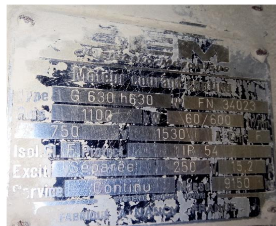
Figure 2. 4 Plaque signalétique du ventilateur « atelier four »
