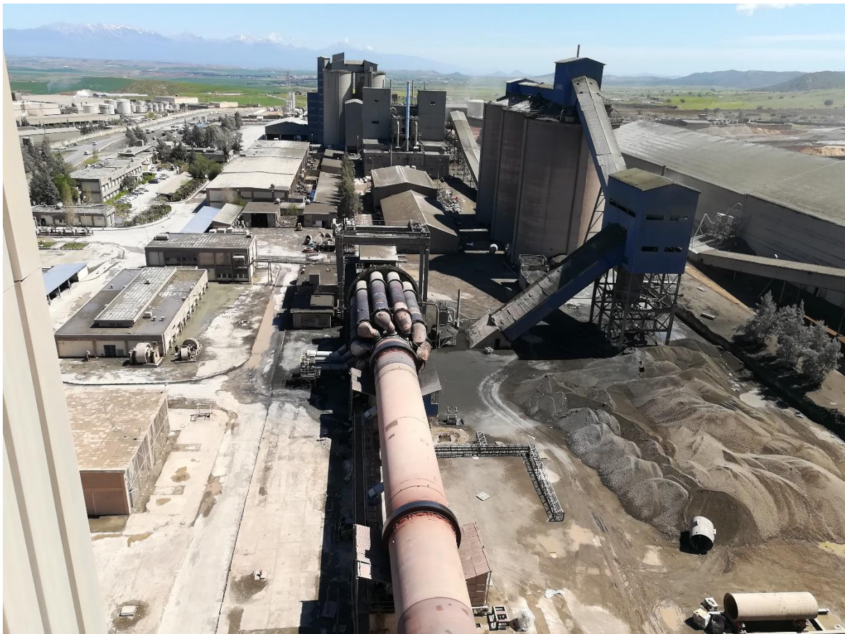
Figure 1. 2 Cimenterie de Sour El Ghozlane
