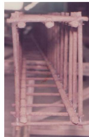
**Photo 4.2 :** Vue du ferrailage des poutres élasto-conforme avec détail des cadres soudés.
