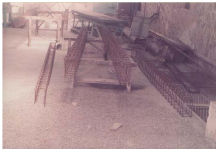
**Photo 4.1 :** Vue du ferrailage des poutres.
