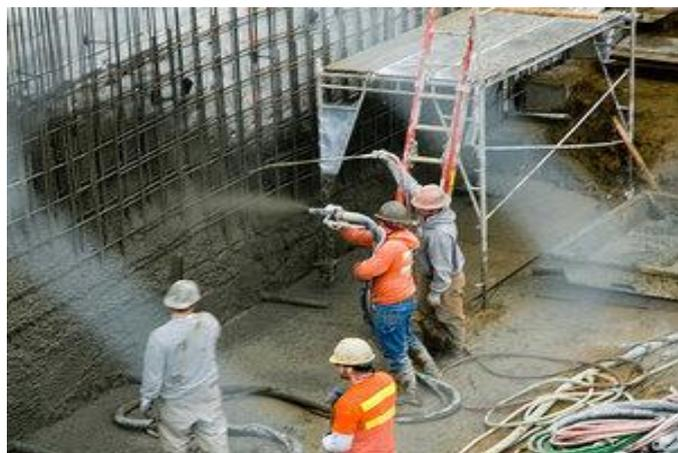
**Figure II.1:**Systèmes De Soutènement Provisoire
