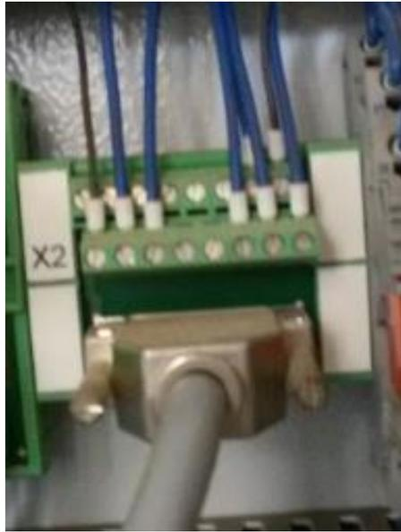
Figure I.2 Terminal d'entrées/sorties analogiques X2
