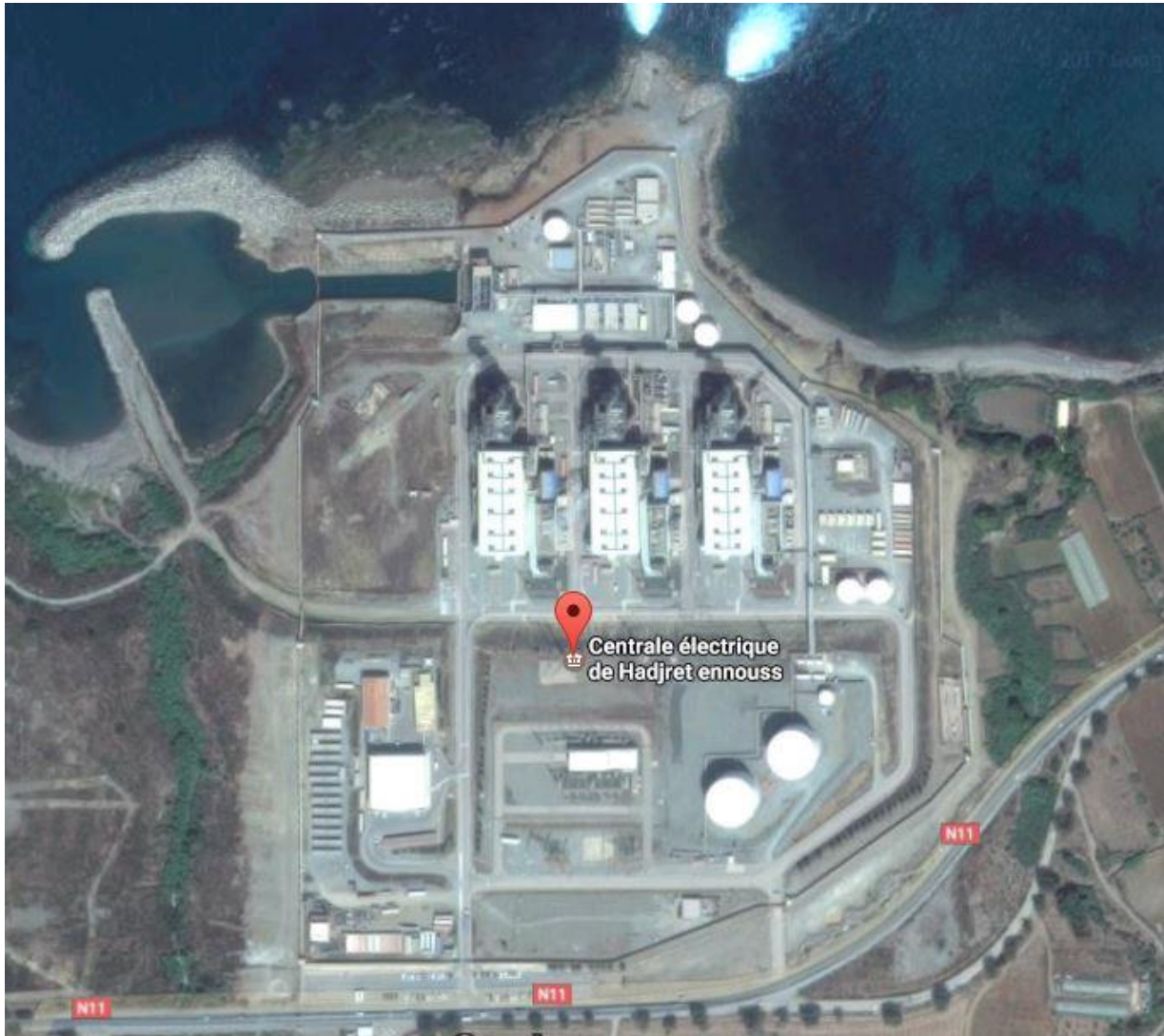
Figure 1-2 - Vue satellite de la centrale à cycle combiné Hadjret Ennoss
