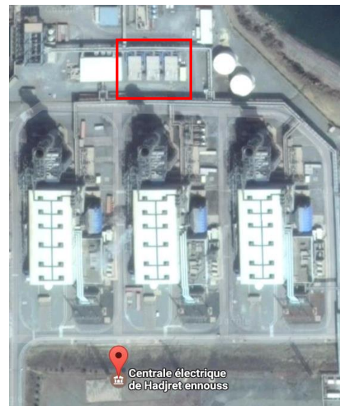
Figure 2-7 - Emplacement des unités de chillers Centrale Hadjret Ennous
