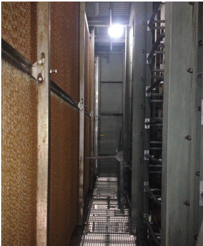
Figure 2-1 - Média du refroidisseur par évaporation (à gauche)
