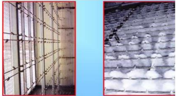
Figure 2-5 - Système de pulvérisation d'eau
