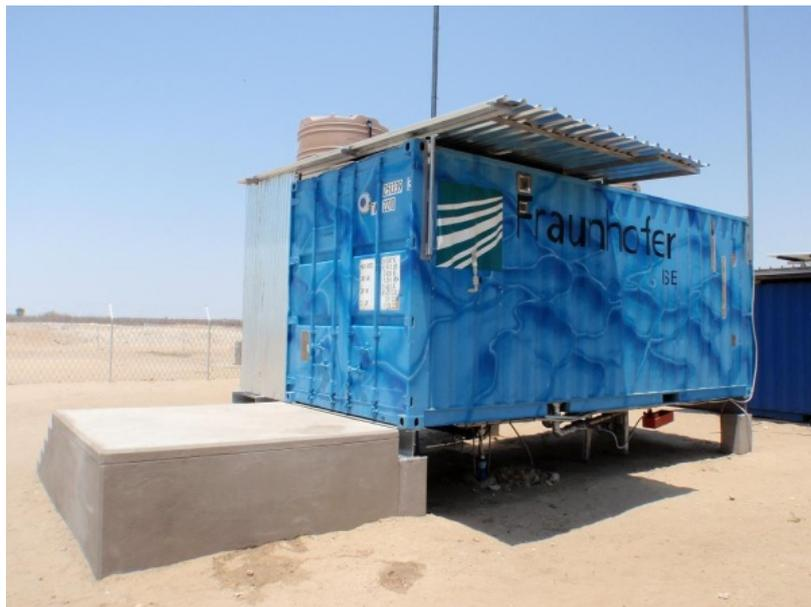
FIGURE 1.10 – Usine de distillation membranaire, installée à l'intérieur d'un conteneur de navire (emplacement : la Namibie)
