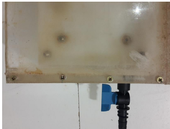
Figure III.14: Photo montrant l'assemblage à vis.
