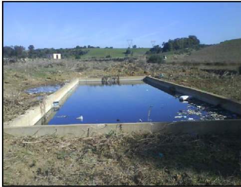
Figure III. 11 : Bassin de décantation des lixiviats.
