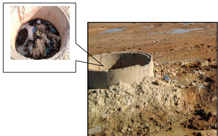
Figure III 10 : Refoulement de lixiviats vers l'extérieur au niveau de la cheminée de récupération des biogaz du Casier N° 1
