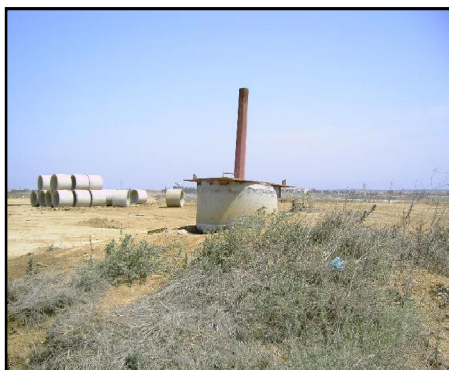
Figure III 9 : Système de récupération de biogaz sans traitement
