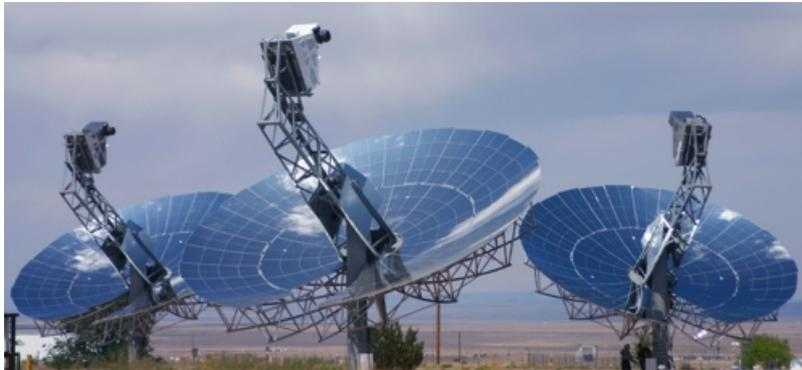
FIGURE 2.12 – Centrale à capteur parabolique
