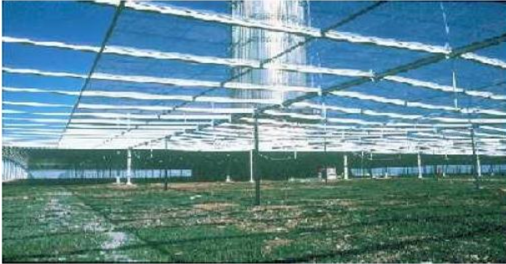
Figure II 2 : Verrière du collecteur d'une cheminée solaire.
