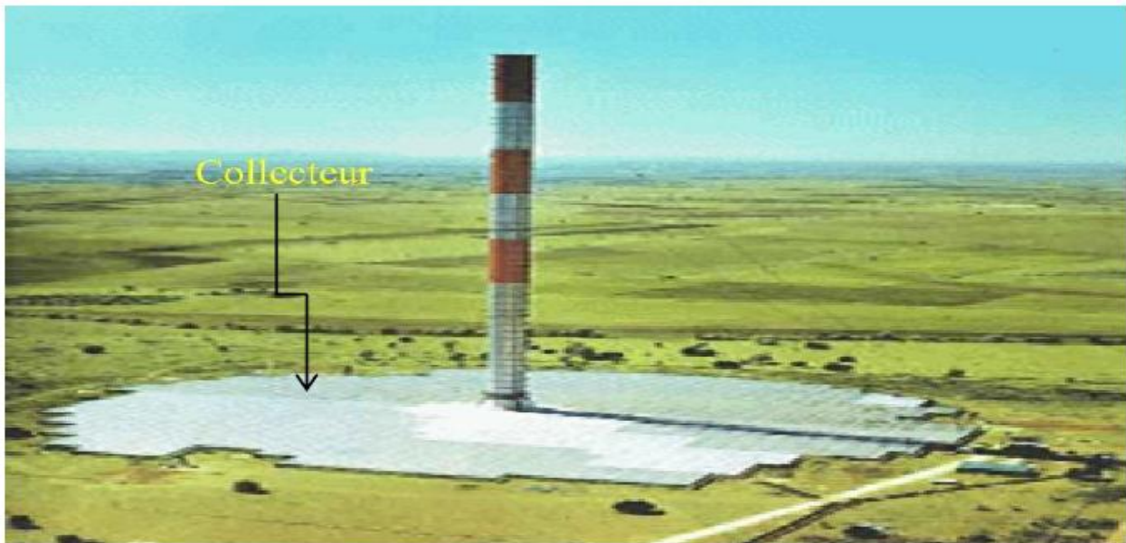
Figure II-3 : Collecteur d'une cheminée solaire.
