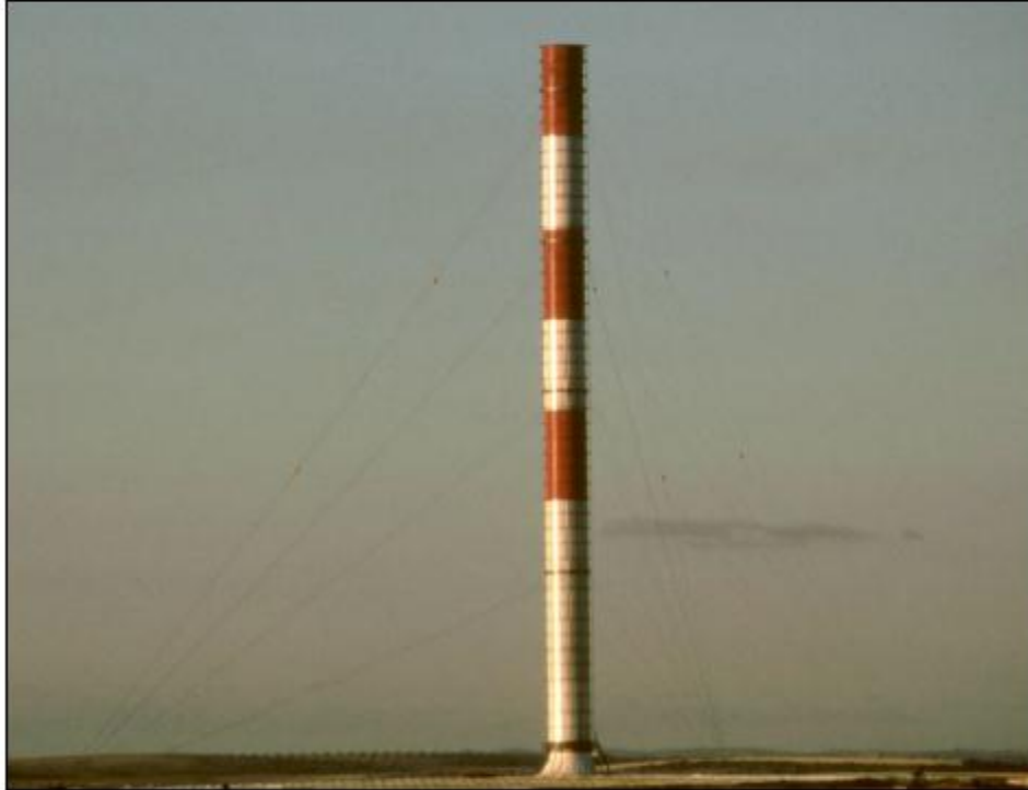
Figure II-4 : Photo montrant une tour cheminée.
