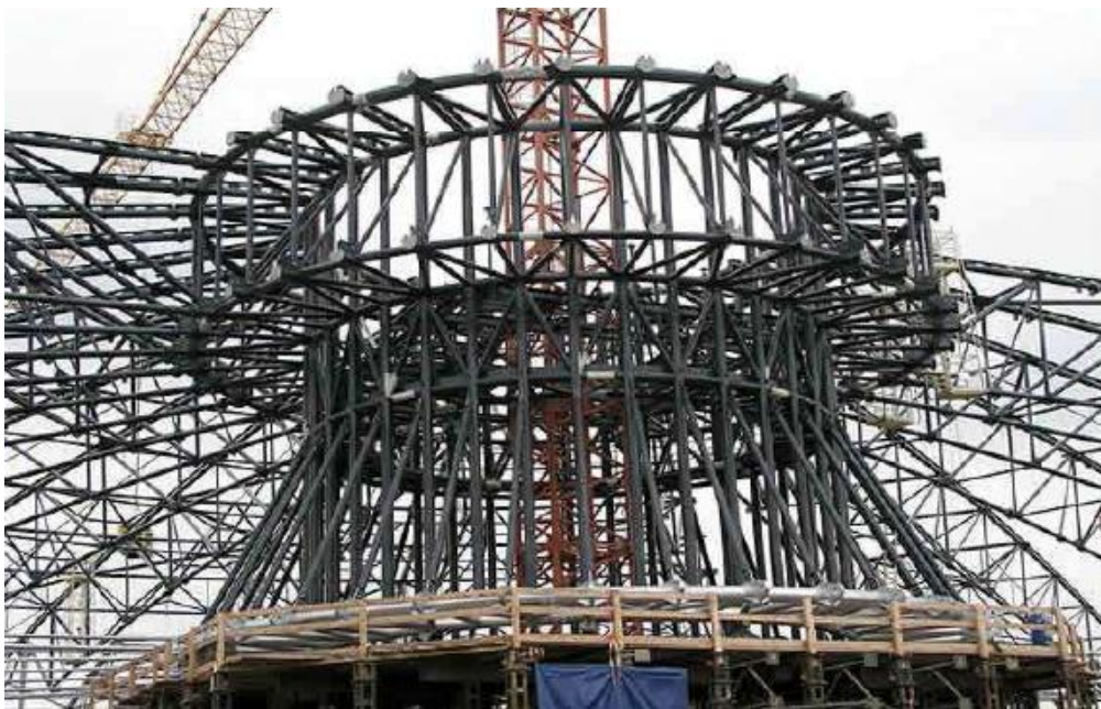
Figure II.13: Structure de la cheminée solaire de Manzanares.
