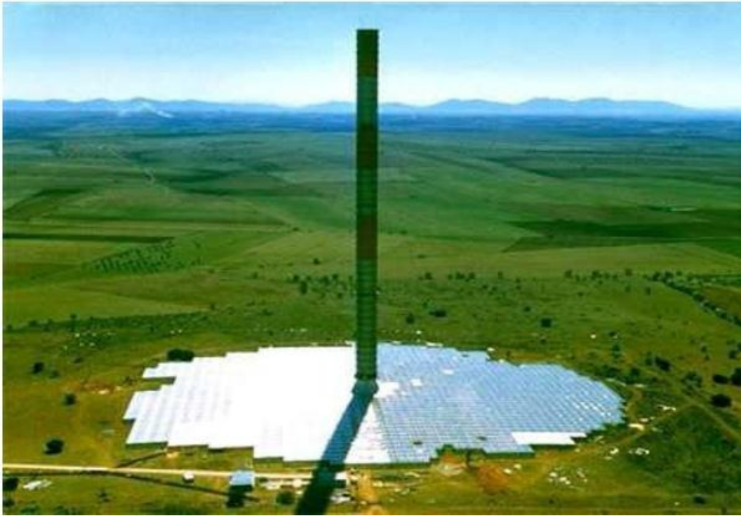
Figure II.12 : Photo de la cheminée solaire de Manzanares.
