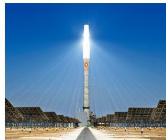
Fig.1.9 : Centrale Gemasolar (Solar tree)
