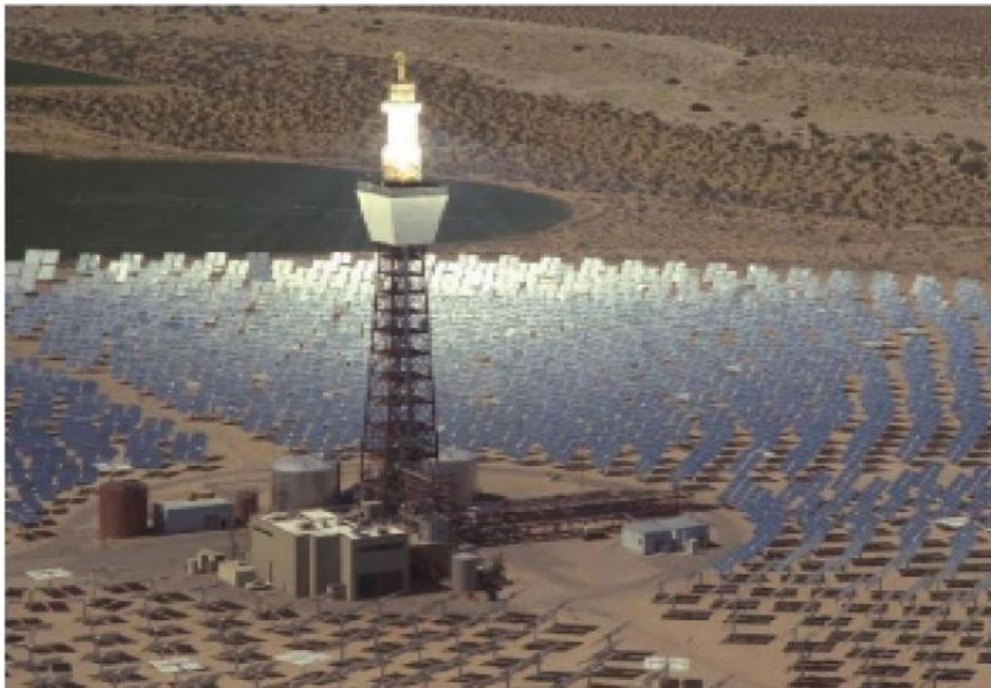
Figure (I. 3) : Tour solaire de Californie.
