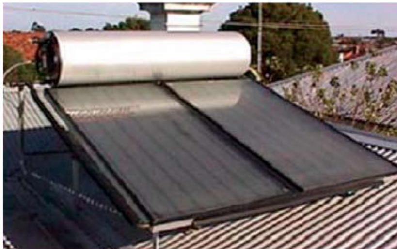
*Figure I.7 : Système de production d'eau chaude domestique(Thermosiphon)*
