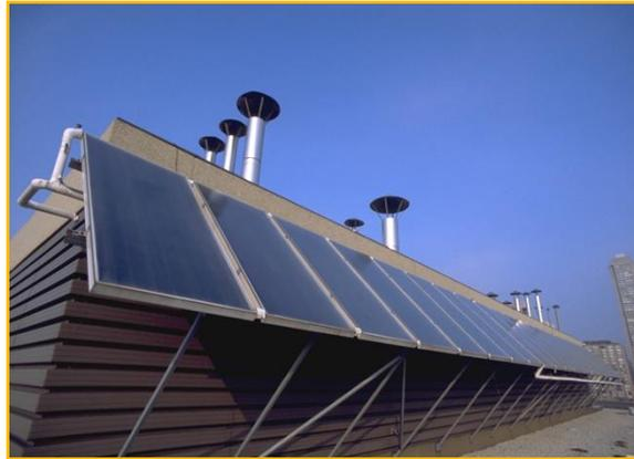
*Figure II.1 : capteur solaire thermique*
