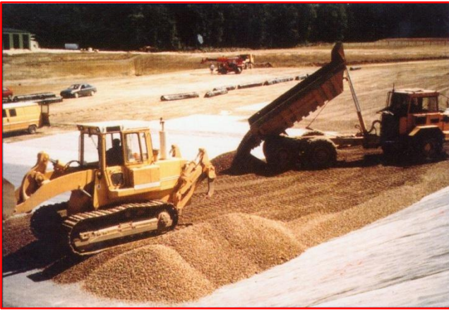
Mise en œuvre de la couche de protection.
