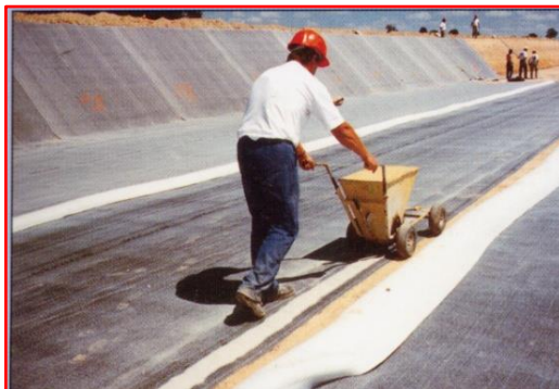
Traitement des zones de recouvrement.
