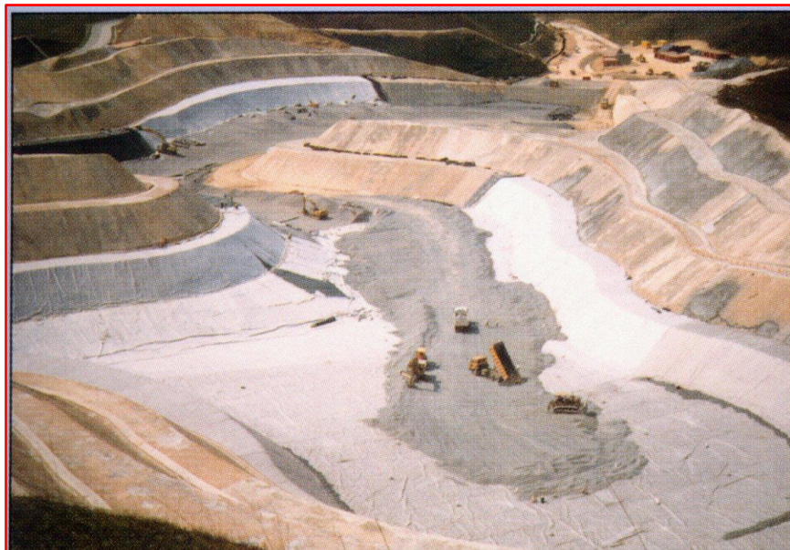
... à l'aménagement de grande envergure; véritable lac artificiel.
