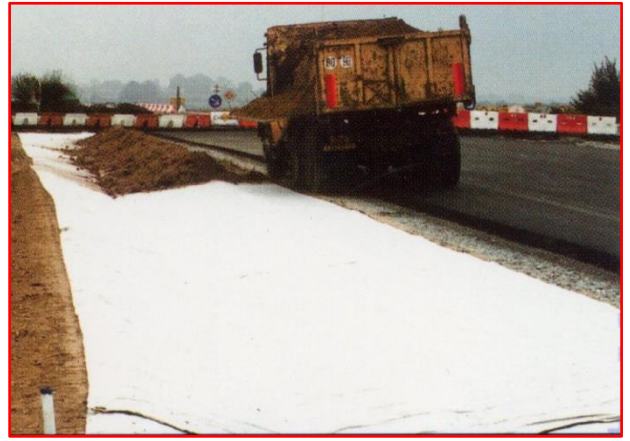
Mise en œuvre de la couche de protection.
