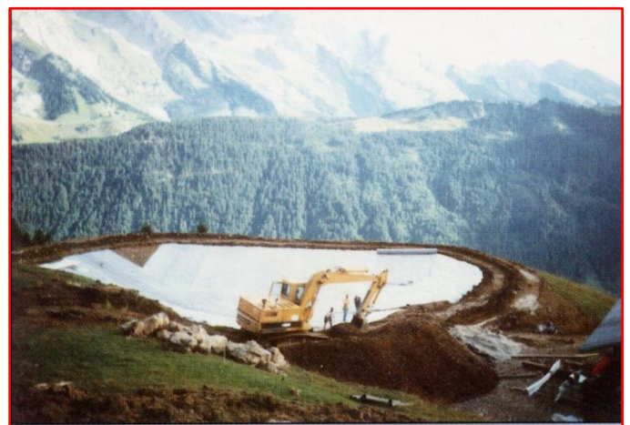
Réalisation de retenues d'eaux de neige et pluviales en régions montagneuses (les altitudes sont supérieures aux sources souterraines d'eau)
