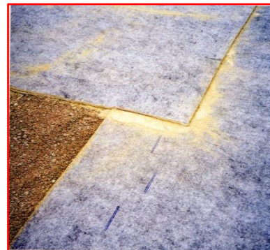
Traitement des zones de recouvrement.
