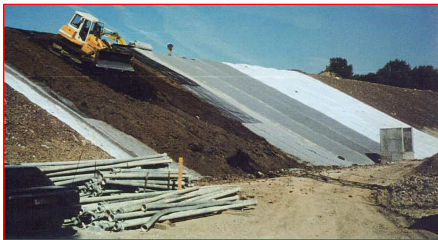
Mise en œuvre de la couche de protection en pente sur GSB surmonté d'un GTX de drainage. Les canalisations sont entreposées au raz du talus pour véhiculer les eaux collectées.
