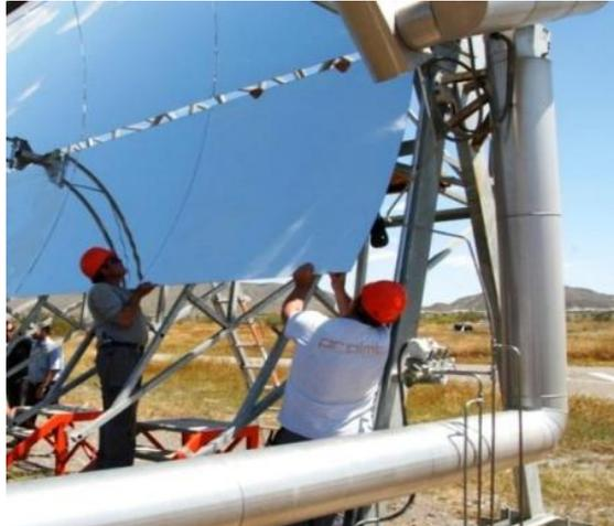
**Figure II.9: Montage des facettes de miroir en verre recouvertes d'argent d'un collecteur cylindro-parabolique [24]**
