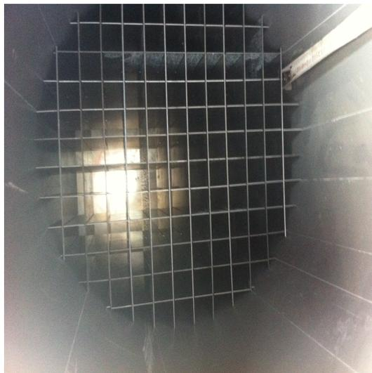
FIGURE 2.18: Fixation du redresseur dans le conduit
