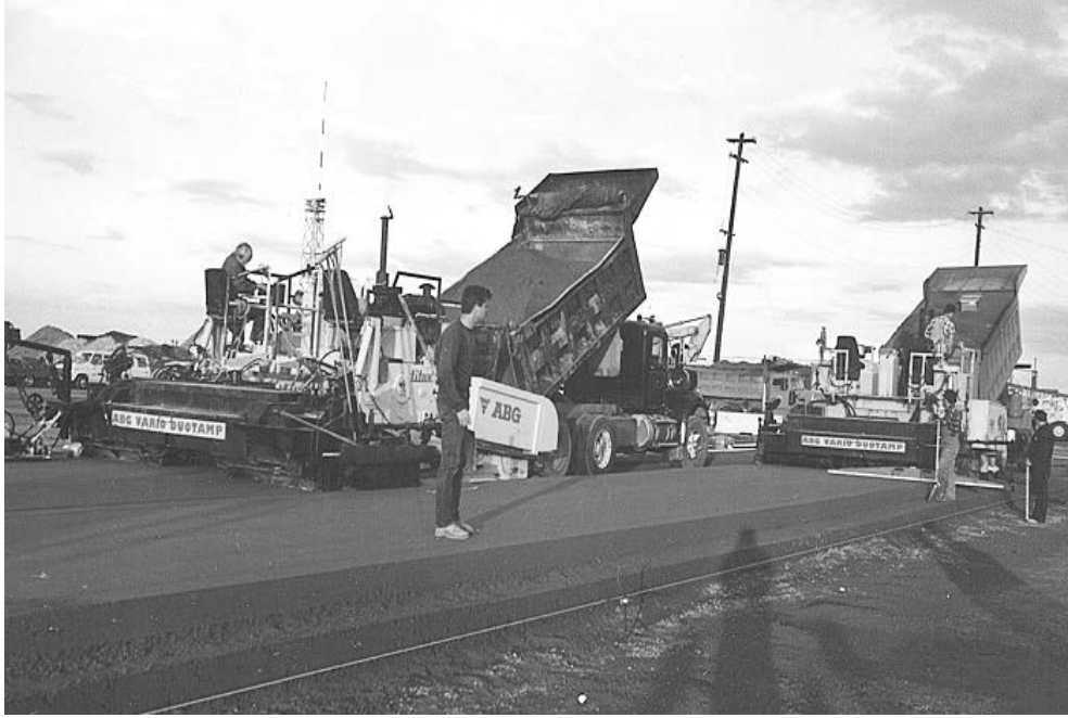
Fig. 1.2. Mise en place d'un BCR routier (ACI 325, 2001).
