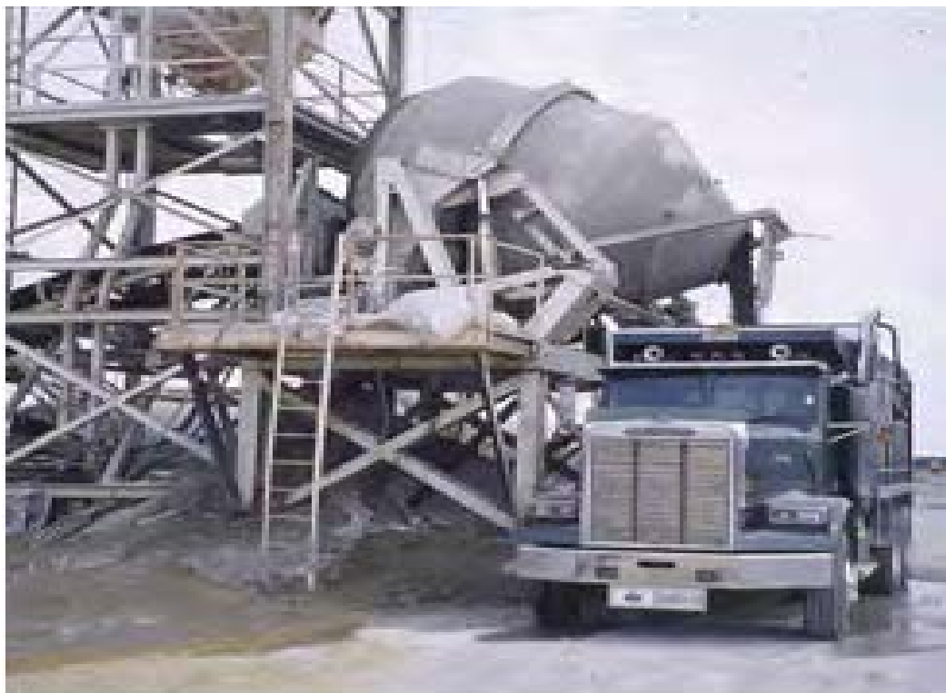
Fig .1. 7. Malaxage du BCR par gachée (Harrington et al., 2010).
