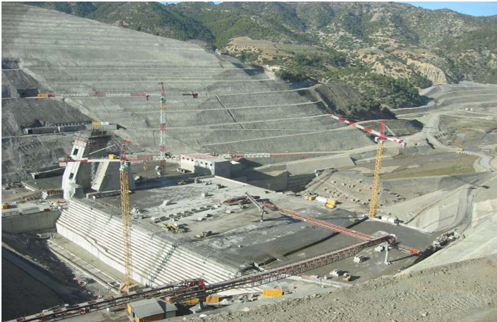
Fig. 1.3. Barrage de Koudiat-Acerdoune en Algérie, pendant la construction (Bouyge & Forbes, 2007).
