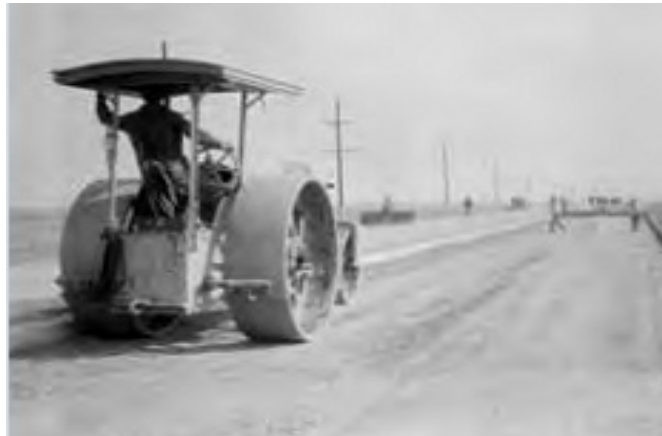
Fig. 1.4. Une technique de pavage considérée comme BCR en Suède en 1930 (Harrington et al., 2010)
