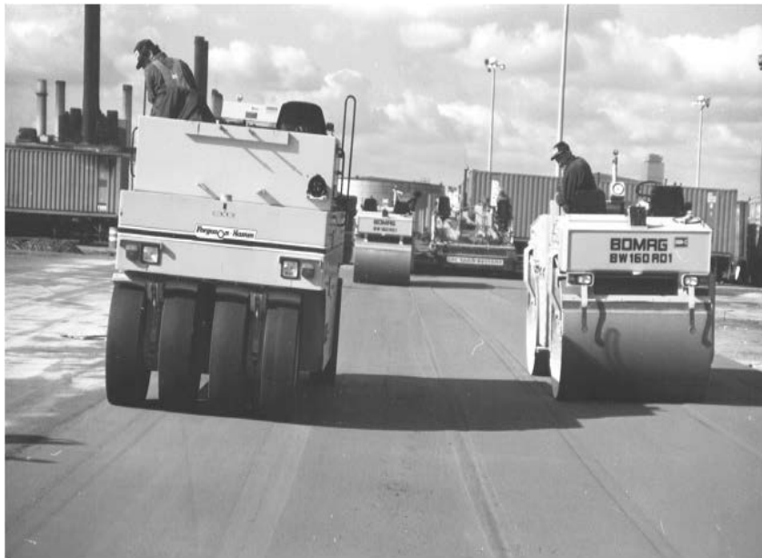
Fig. 1.9. Rouleaux compacteurs sur pneus et cylindres.
