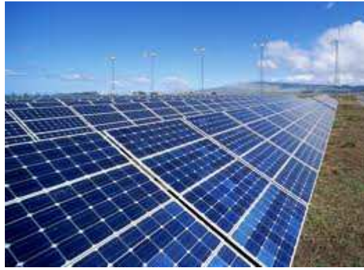
FIG 1-22 : Champ de modules photovoltaïques
