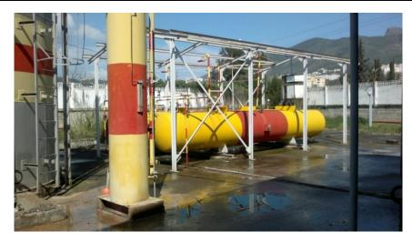
Fig. 5.4. Réservoir d'hydrogène pressurisé de l'unité de production d'hydrogène.
