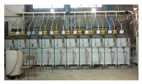
Fig. 5.1. Cellules électrolytiques alcalines de l'unité de production d'hydrogène.
