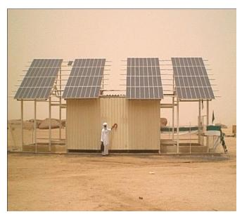
Fig. 3.2. Panneau photovoltaïque monté sur le toit de la salle des batteries.
