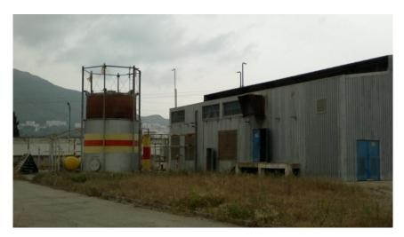
Fig. 5.2. Gazomètre ou réservoir d'hydrogène faible pression de l'unité de production d'hydrogène.
