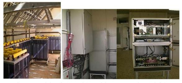
Fig. 3.3. Banc de batteries (à gauche) et onduleur MLI monophasé (à droite).
